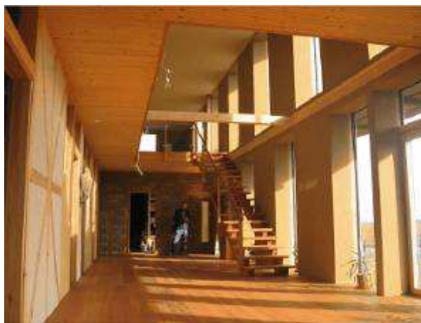
Obr. 8 - Na vnitřní interiér se použily pouze dřevěné a hliněné materiály.
