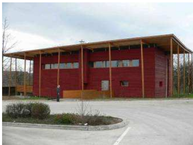
Obr. 35 – Všechna prkna venkovního obkladu byly k podkladu připevňovány dřevěnými kolíky.
