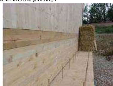
Obr. 34 – Dřevěné sloupky a nosné stěny tvořené dřevěnými panely.
