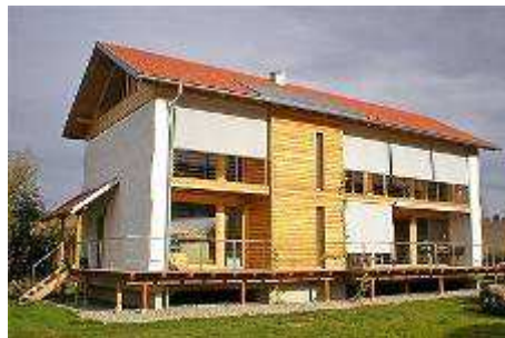
Obr. 5 – Nízkoenergetický slaměný dům - St. Donat, Rakousko.
