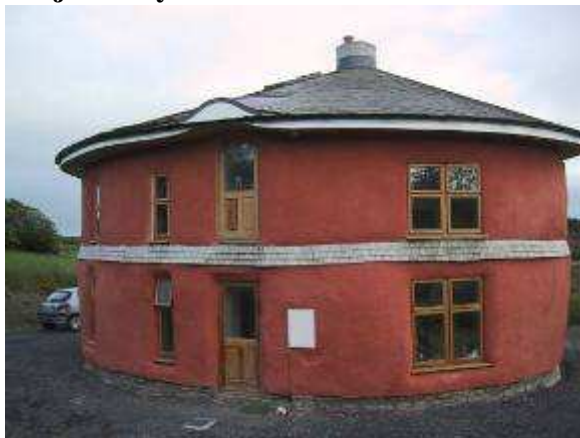
Obr. 51 – Venkovní povrch balíků je opatřen dvěma vrstvami hliněné omítky a poté třemi vrstvami omítky vápenné.
