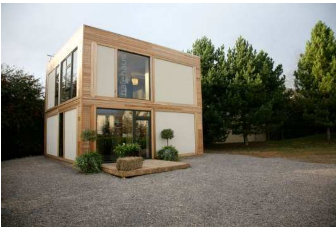
Obr. 62 – Fotografie předváděcího objektu, který je složen z předem vyrobených slaměných panelů.
