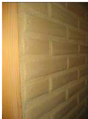
Obr. 9 - Nepálené hliněné cihly spojované hliněnou maltou.
