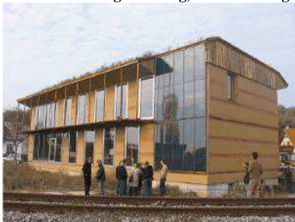
Obr. 7 - Jižní fasáda s fotovoltaickými panely a bezúdržbovou vegetační střechou.
