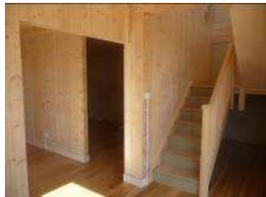
Obr. 66 – Schodiště, vnitřní stěny spodního patra a také všechny stropy jsou tvořeny dřevěnými nosnými panely.
