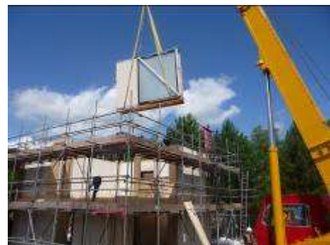
Obr. 66 – Schodiště, vnitřní stěny spodního patra a také všechny stropy jsou tvořeny dřevěnými nosnými panely.
