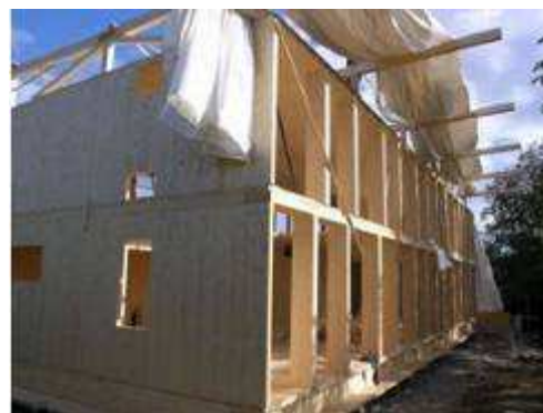
Obr. 34 – Dřevěné sloupky a nosné stěny tvořené dřevěnými panely.
