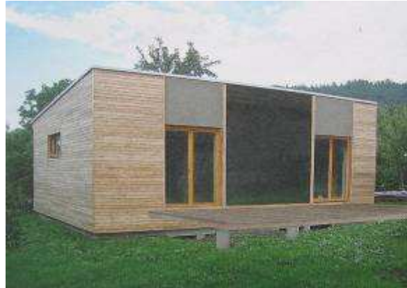
Obr. 56 – Z útrobu teplovzdušného kolektoru umístěného mezi okny odvádí ventilátor sluncem ohřátý vzduch do vnitřní dvojité přičky z vápenopískových cihel.
