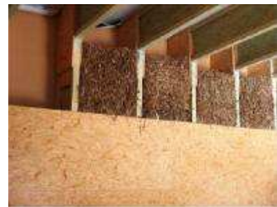
← ↓ → Obr. 58, 59, 60 - Instalace slaměných balíků mezi dřevěné rámy. Tato varianta je z hlediska časové náročnosti a potřeby pracovní síly velice výhodná, zaizolování celého domku trvalo dvěma lidem necelé dva dny.
