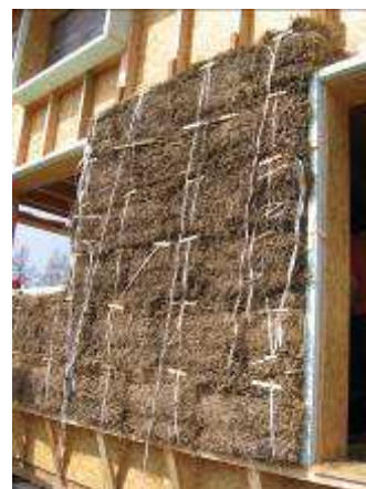
Obr. 45 – Nosná dřevěná konstrukce, ke které se balíky přivazují textilními pásky.
