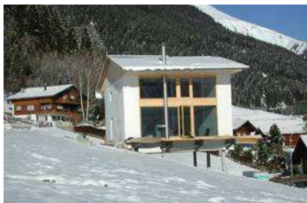
Obr. 39 – Pohled na jižní prosklenou stěnu objektu.
