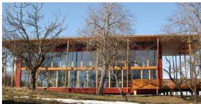
Obr. 32 - Jižní prosklená stěna zachytávající zimní sluneční energii.
