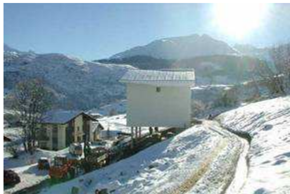
Obr. 40 – Ze zadního pohledu na objekt je patrný velký sklon terénu.
