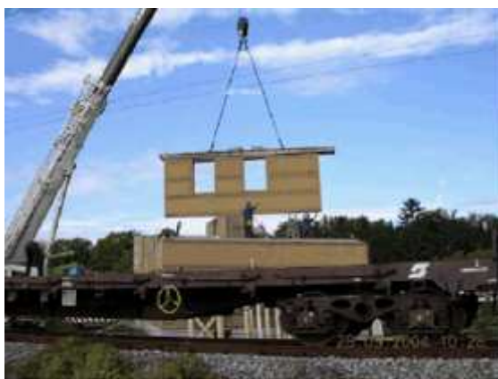
Obr. 11 - Vyrožení předem vyrobených stěnových dílců z přilehlé železniční tratě.
