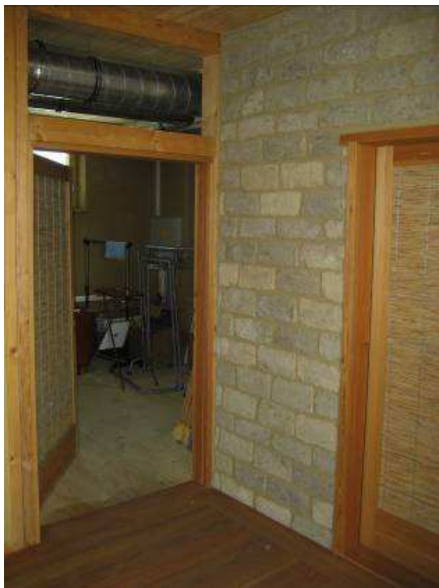
Obr. 10 - Dřevěné rámové zárubně ve stěně vystavěné z hliněných cihel.
