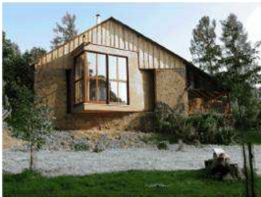
Obr. 47 – Rekonstrukce kamenné stodoly, do níž se zapustila krychle, tvořená slaměnou izolací sloužící k obytným účelům - Česká Republika 2008.
