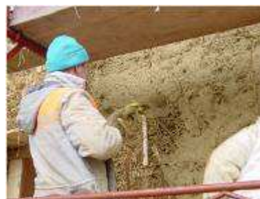
Obr. 38 - Strojní nanášení hliněné omítky na slaměný podklad.
