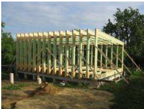
Obr. 57 - Dřevěná rámová konstrukce je rozmístěna v takové vzdálenosti, aby se mezi ně mohly balíky pohodlně napasovat.
