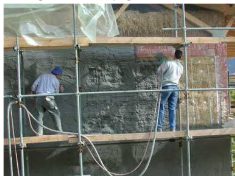
Obr. 44 – Omítání slaměných stěn z obou stran vápenocementovou omítkou tloušťky 8 cm, ta by pak měla částečně přebírat zatížení.
