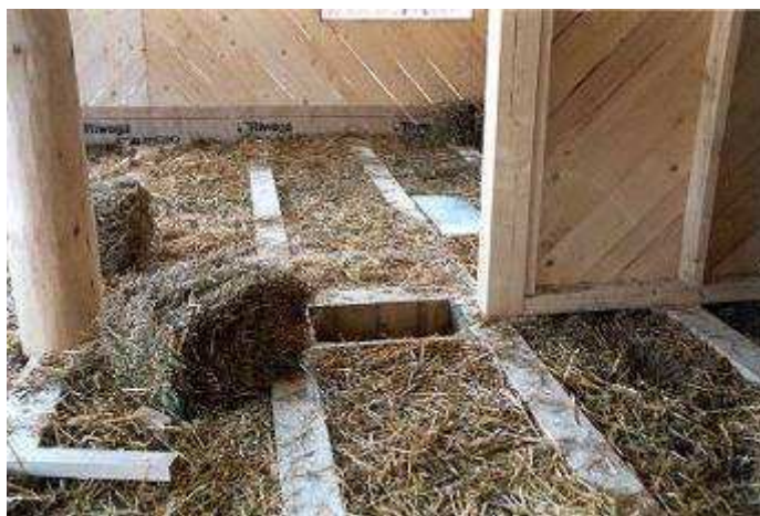
Obr. 29 – Princip skladby stěn s balíky se dá bez podstatné změny uplatnit také u vodorovných konstrukcí jako jsou podlahy.
