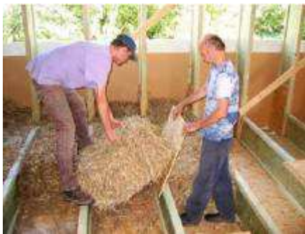
← ↓ → Obr. 58, 59, 60 - Instalace slaměných balíků mezi dřevěné rámy. Tato varianta je z hlediska časové náročnosti a potřeby pracovní síly velice výhodná, zaizolování celého domku trvalo dvěma lidem necelé dva dny.
