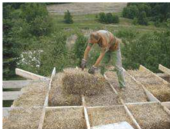
Obr. 28 – Vyplňování předem připravených mezer mezi dřevěným roštem ve střešní konstrukci.
