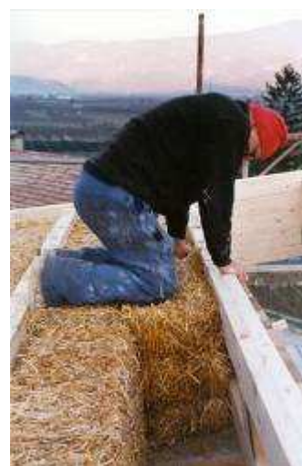
Obr. 46 – Pasování slaměných balíků do střešní konstrukce, mezeru je pro ně předem připravena.
