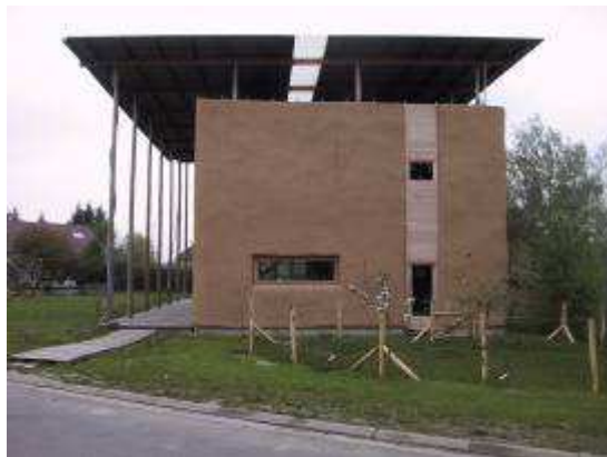
Obr. 19 - Boční pohled na venkovní hliněnou úpravu stěny.
