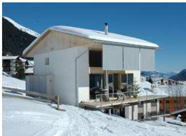
Obr. 41 – Obytnou terasu a vnitřní prostory domu chrání přesah střechy spolu s textilní sluneční clonou.
