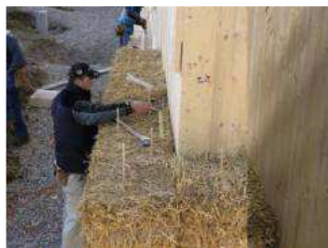
Obr. 37 - Pokládání balíků a jejich vzájemné provázání kolíky.
