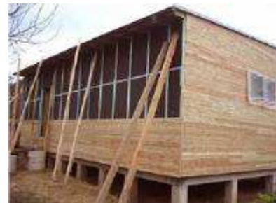
Obr. 61 - Obkládání venkovních stěn modřínovými prkny
