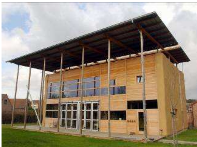
Obr. 18 - Prosklená fasáda objektu s dřevěným obkladem a terasou, kterou kryje horní přesah střechy.
